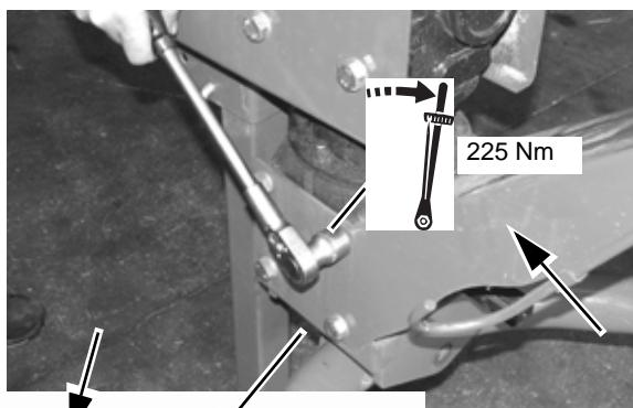
Monter beslag for slangeholder og spænd bolte på svinggear til det angivne moment. Monter flexslange omkring alle hydraulikslanger og ledninger. Monter spændebånd i hver ende af flexslangen og led den igennem holderen som vist.
